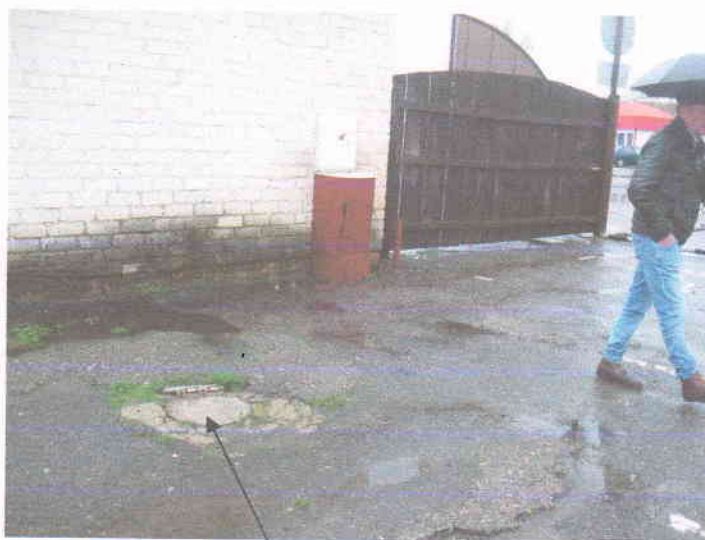
05.11.2019 г. Литер в Канализационный выпуск (выгреб)
