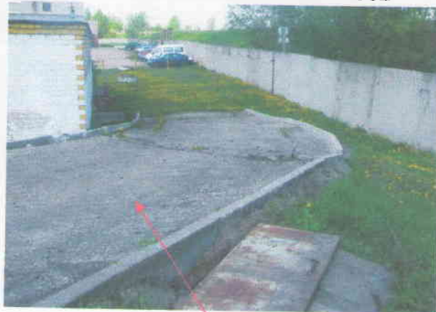
подъездная дорога к подземному хранилищу
