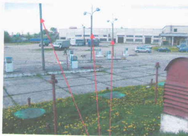
опоры освещения АЗС
